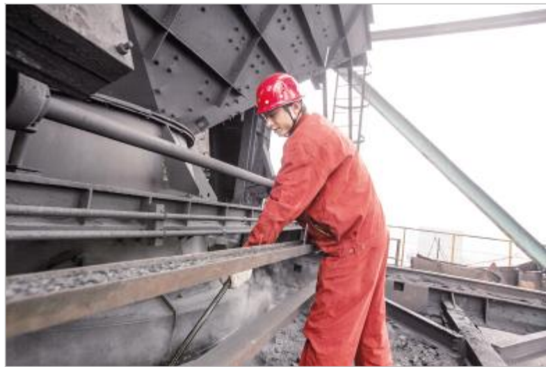
▲蔡红日 连钢焦化厂干熄焦车间干熄炉作业区大班班长
